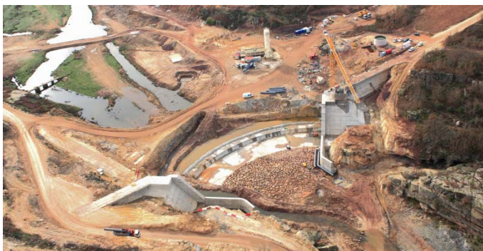
Presa de los Vados
